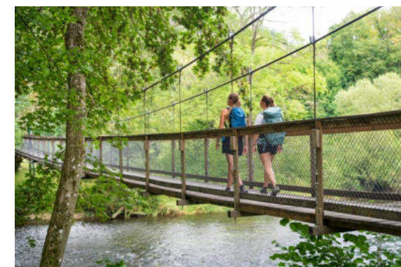
Hängebrücke bei der Einsiedlerwiese
